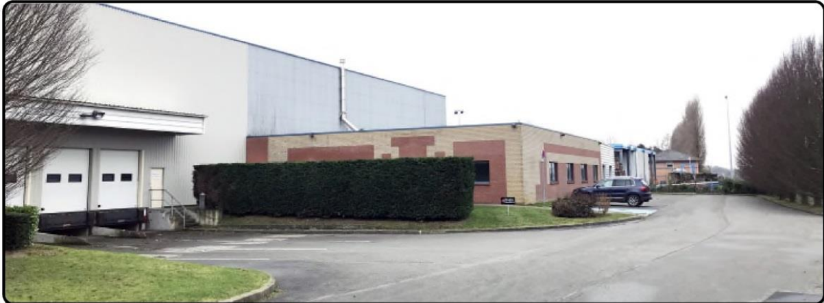
Vue du bâtiment montrant la partie bureaux (bureau d'étude KALIÈS)
